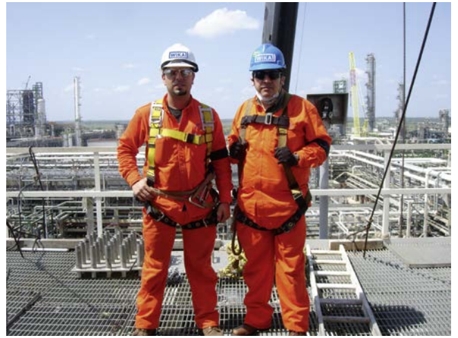
Equipe d'installation sur site
