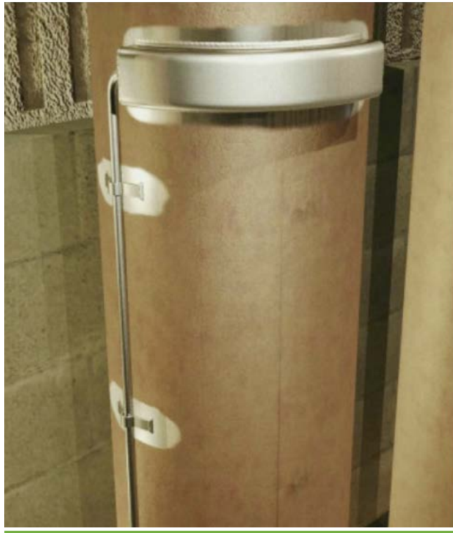
Installation correcte avec attaches
