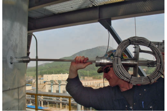
Un collaborateur de l'équipe service après vente installe un Radial Tap
