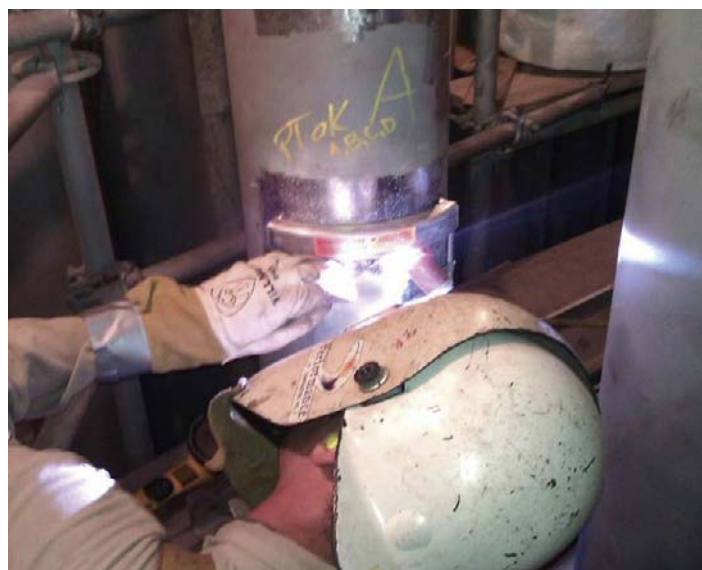
Thermocouple „Tubeskin“ installé par un spécialiste ayant suivi une formation
